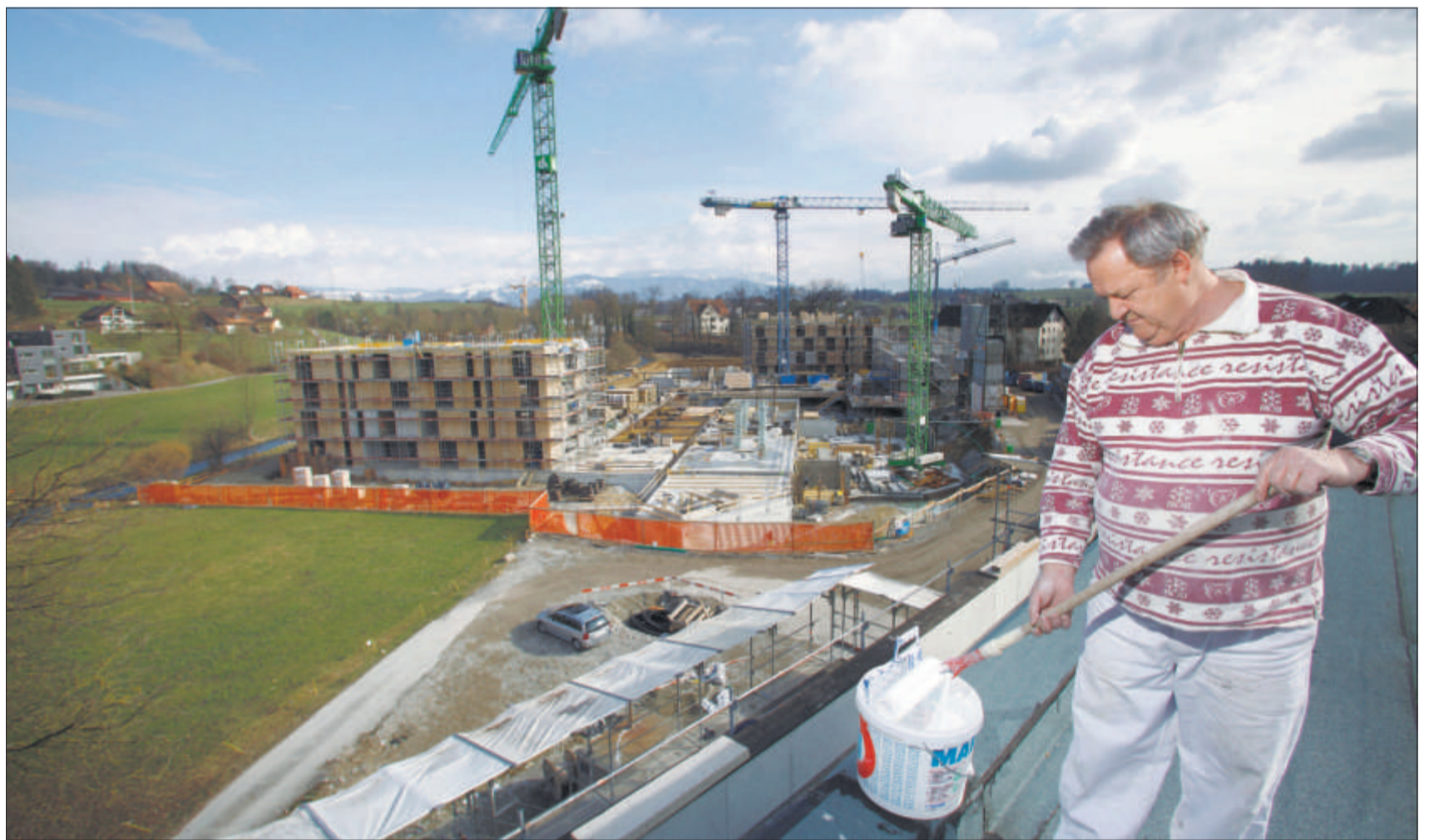
Das Dorf stösst in städtische Dimensionen vor: Auf dem Dach des Penthouses über dem darunter befindlichen Volg-Laden arbeitet Matic Bratislav. Im Hintergrund ist der andere Teil der Arealbebauung Lorze zu sehen.
