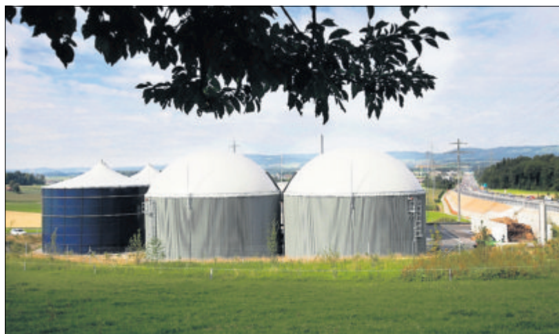
Hier am Standort in der Fildern will die BiEAG bis 2014 einen zweiten Holzschnitzelkessel einbauen.
