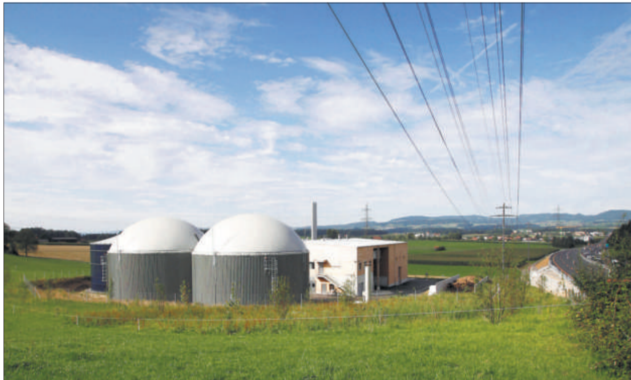
In wenigen Jahren soll es das halbe Dorf mit Wärme versorgen: das Biomasse-Kraftwerk in der Fildern.
